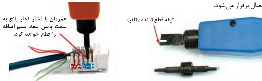
شکل ۳۳- قرار دادن سیم‌ها در کیستون به کمک آچار پانچ
